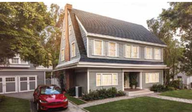
Die Solarmodule von Tesla sind optisch nicht von herkömmlichen Dachziegeln zu unterscheiden. Foto: Tesla
