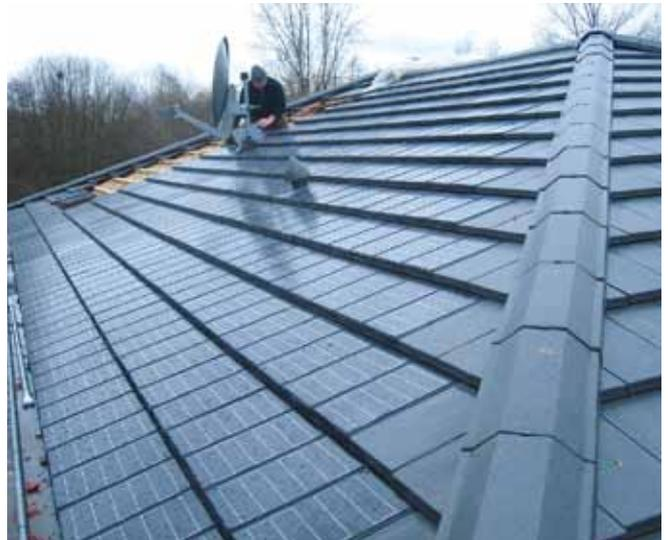
Die Strom erzeugenden Solardachziegel von Autarq bestehen aus Ton oder speziellem Beton. Foto: Autarq
