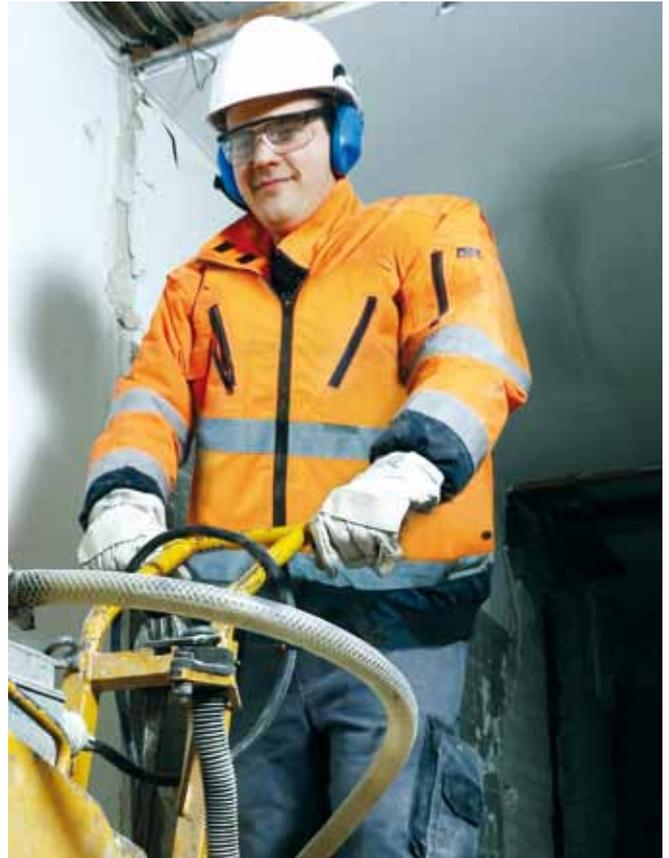
*Auf Baustellen kommt es immer wieder zu gefährlichen Augenverletzungen, die im schlimmsten Fall bleibende Schäden bis hin zur Erblindung zur Folge haben können. Eine Schutzbrille sollte deshalb bei der Arbeit auf dem Bau zur Grundausrüstung gehören. Foto: Mirko Bartels/BG Bau*
