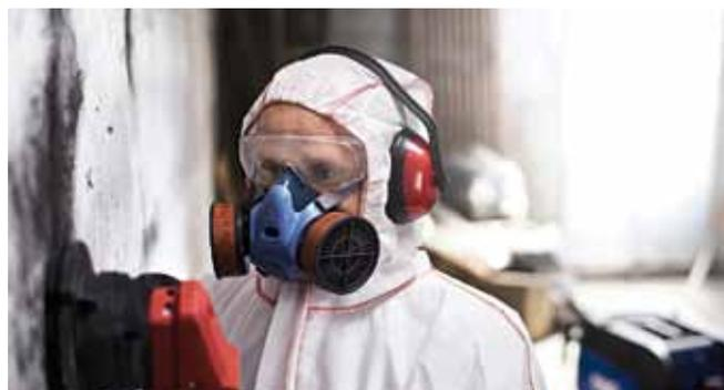
Bei der Bearbeitung von gefährlichem Asbest darf nicht jeder Industriesauger eingesetzt werden. Fotos: Nilfisk
