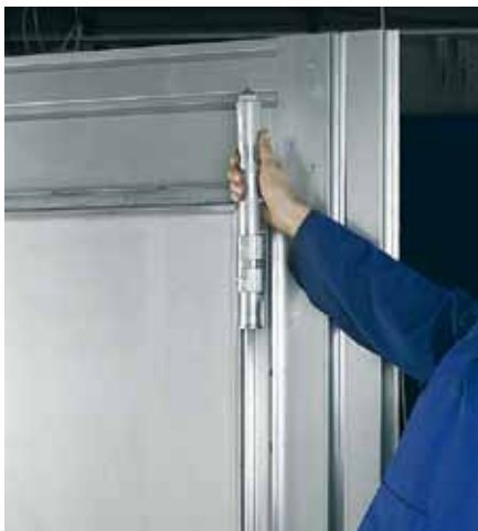
Die Baustellen-Schutztüren des Arnberger Unternehmens sind schnell montiert: Die zweifach geführten Spanndorne mit Arretierzapfen werden einfach aus der Grundposition gelöst und um 90° gedreht. Anschließend werden sie unter den Sturz gehoben und in die nächste Rastposition gebracht. Der massive Sechskantkopf mit Bohrspitze wird mit einem 27er-Maulschlüssel fest unter dem Sturz arretiert.
