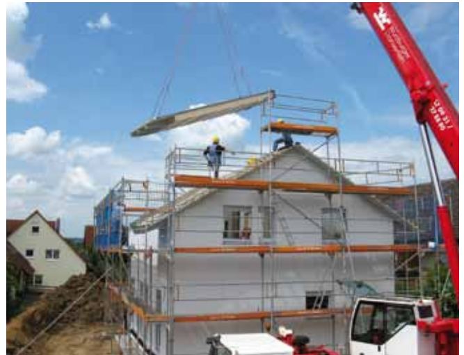
Bei Arbeiten in luftiger Höhe sollte stets auf die richtige Sicherung geachtet werden. Foto: pixabay
