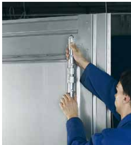
Die Baustellen-Schutztüren des Arnberger Unternehmens sind schnell montiert: Die zweifach geführten Spanndorne mit Arretierzapfen werden einfach aus der Grundposition gelöst und um 90° gedreht. Anschließend werden sie unter den Sturz gehoben und in die nächste Rastposition gebracht. Der massive Sechskantkopf mit Bohrspitze wird mit einem 27er-Maulschlüssel fest unter dem Sturz arretiert.
