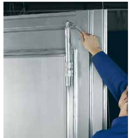
Die Baustellen-Schutztüren des Arnberger Unternehmens sind schnell montiert: Die zweifach geführten Spanndorne mit Arretierzapfen werden einfach aus der Grundposition gelöst und um 90° gedreht. Anschließend werden sie unter den Sturz gehoben und in die nächste Rastposition gebracht. Der massive Sechskantkopf mit Bohrspitze wird mit einem 27er-Maulschlüssel fest unter dem Sturz arretiert.
