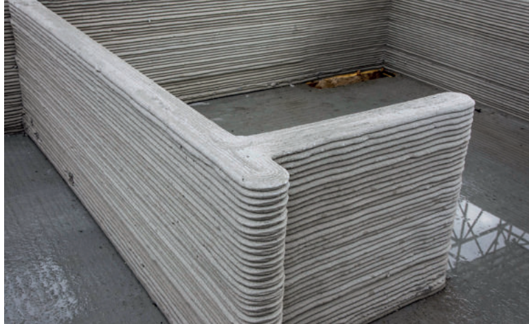
Schicht für Schicht wächst das Gebäude in die Höhe. Leistungsstarke Portaldrucker erreichen eine Geschwindigkeit von bis zu 18 m/min.
