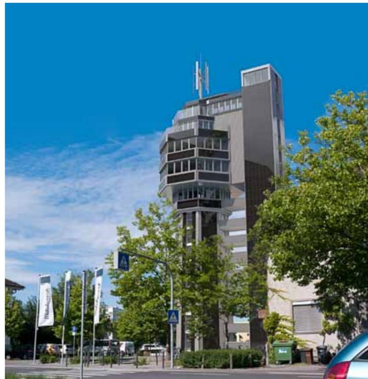
↑ Der Entwurf sieht vor, dass die einzelnen Etagen des aquaTurms über einen Versorgungsturm (rechts im Bild) erreicht werden.
