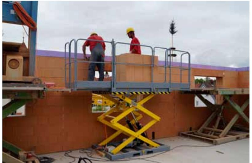
↑ Mittels Einsatz einer Doppelschere muss auch bei der Hubhöhe der Bühne kein Kompromiss eingegangen werden.
