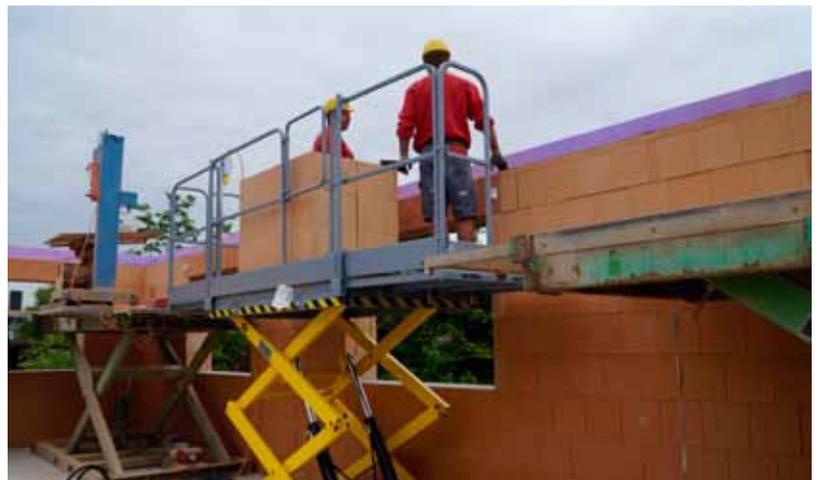
↑ Die neue MAB 1200 ermöglicht ergonomisches Arbeiten bei unterschiedlichsten Gegebenheiten auf der Baustelle. Fotos: LISSMAC
