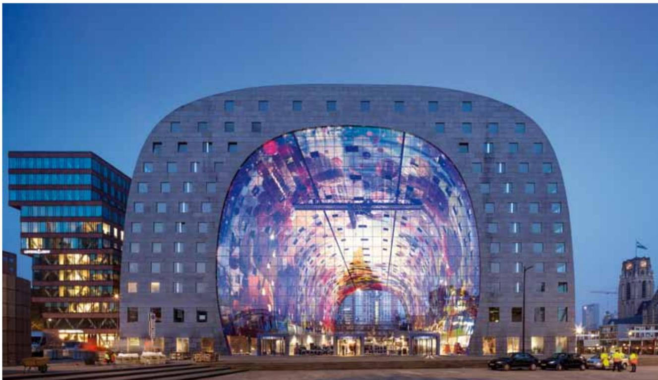
↑ Die beiden Stirnseiten der Markthal bestehen aus Glasscheiben, die zwischen gitternetzartig gespannten Stahlseilen klemmen.
