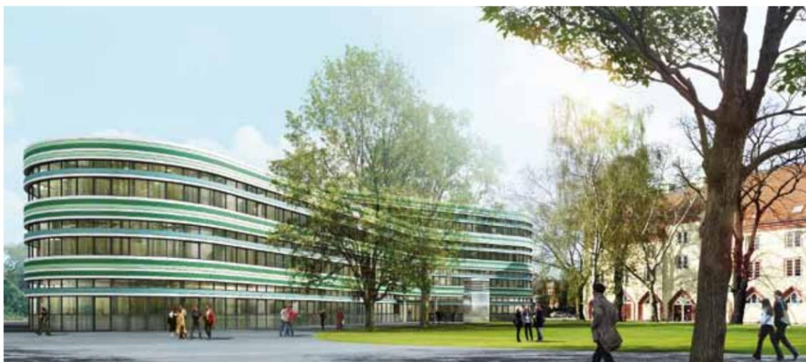
↑ Das äußere Erscheinungsbild des Laborgebäudes ist durch eine umlaufende Bandfassade aus schmalen langformatigen, in Grün-Silber-Tönen beschichteten Aluminiumplatten gekennzeichnet. Foto: Bodamer Architekten
