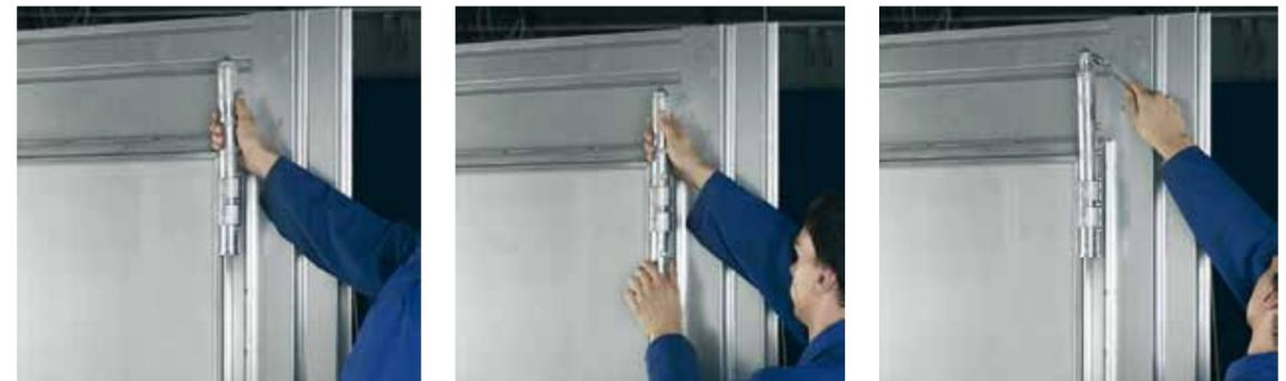
↑ Die Baustellen-Schutztür ist schnell montiert: Die zweifach geführten Spanndorne mit Arretierzapfen werden einfach aus der Grundposition gelöst und um 90 Grad gedreht. Anschließend werden sie unter den Sturz gehoben und in die nächste Rastposition gebracht. Der massive Sechskantkopf mit Bohrspitze wird mit einem 27er-Maulschlüssel fest unter dem Sturz arretiert.
