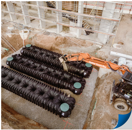
75.000 Liter in Reih und Glied auf einem Kiesbett: Drei Flachtanks in einer Tiefe von 2,75 Metern
