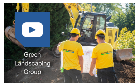
Foto: Green Landscaping Deutschland GmbH
