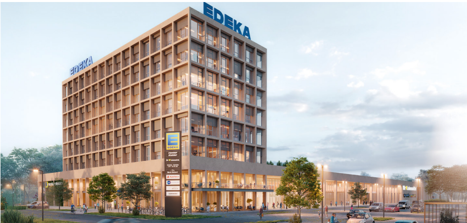
Die Fläche über den Flachtanks wird nach der Fertigstellung gepflastert und als Abstellfläche für Fahrräder genutzt
